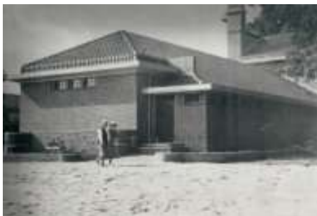
Voorjaar 1932: Juffrouw Warmerdam en juffrouw Eenhorst inspecteren de school in aanbouw. Het schoolplein is nog niet betegeld.
